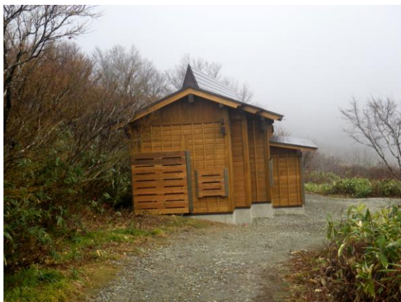
金沢峠付近に新しく設置されたトイレ
