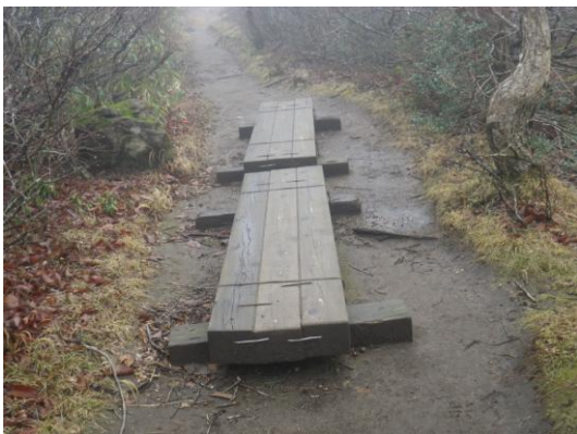
エコツアー協会で設置した木道 (1)
