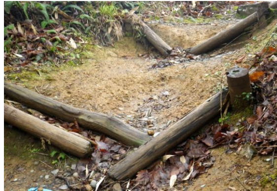
休憩舎付近の階段の壊れた箇所
